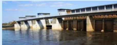
Wasserkraftanlage an der Weser, © Foto: R. Gerken
